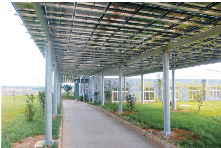
光伏走廊——兼具遮光挡雨的实用功能与发电能力。
