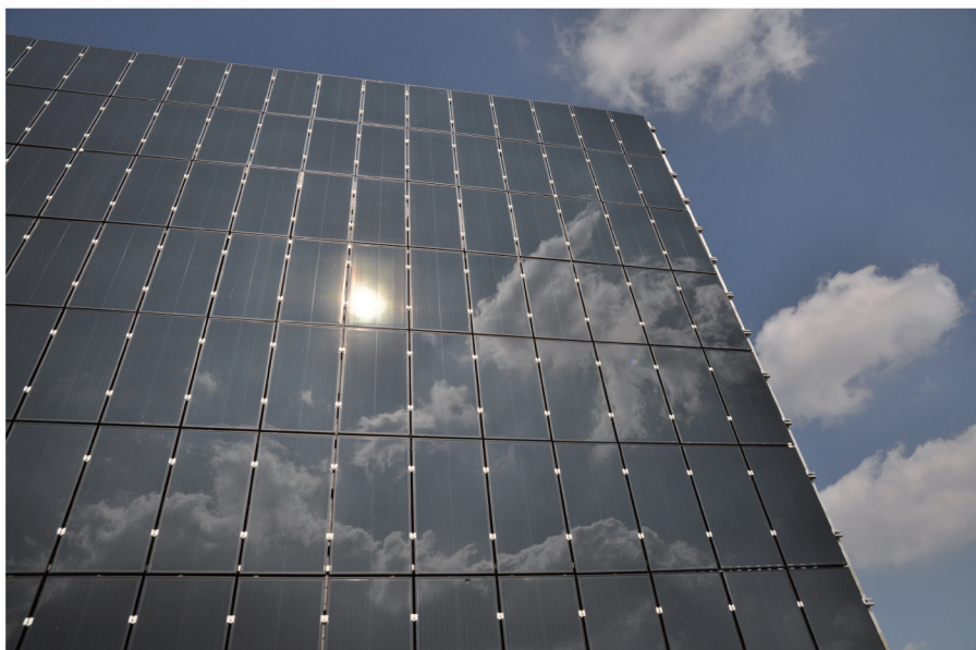
光伏玻璃幕墙——兼具发电与室内采光
